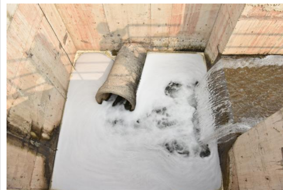
污水市政管网接口
