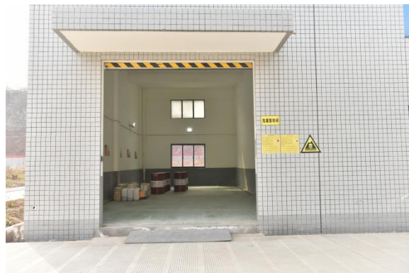
危废暂存间外部
