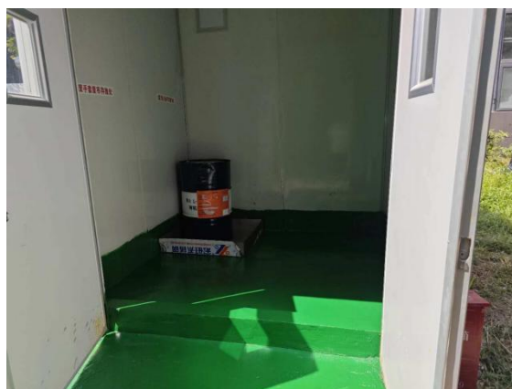
危险废物贮存点内部
