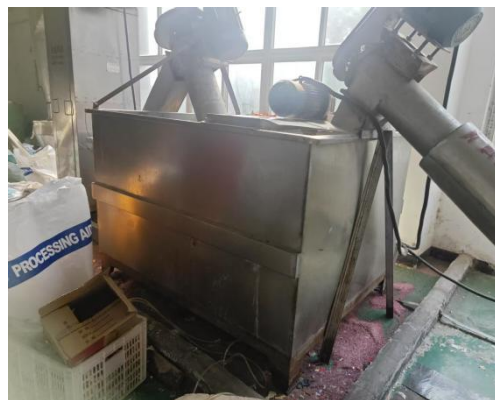
塑料清洗沉淀池
