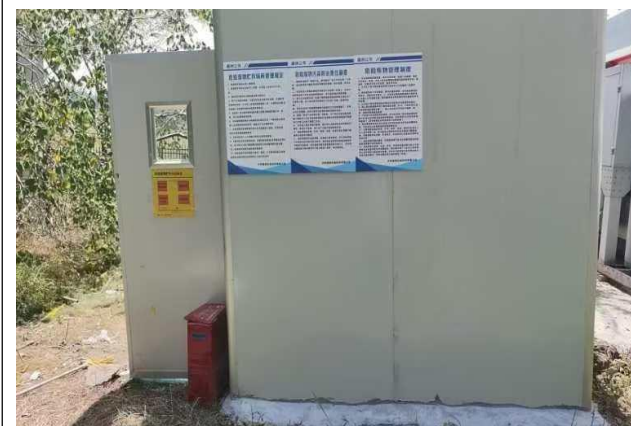
危险废物贮存点外部
